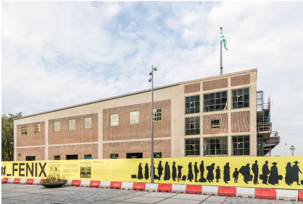
De oostgevel van de Fenixloods II na restauratie, foto: Sylvana Lansu
